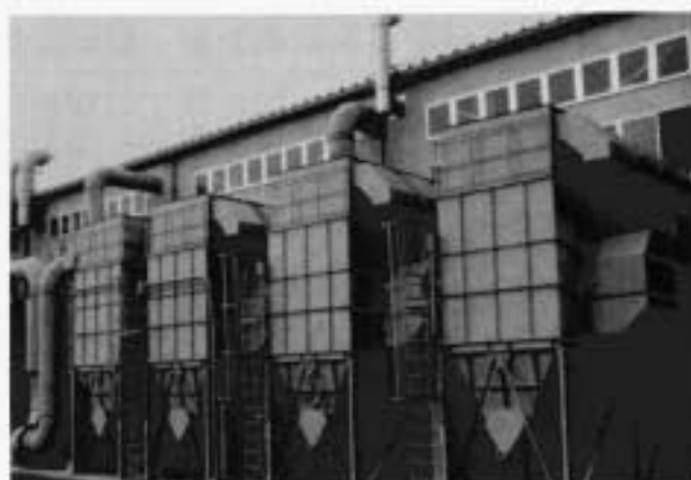
バグフィルター施工例
