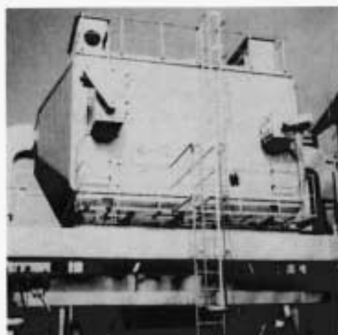
CEC式 電気集塵装置
